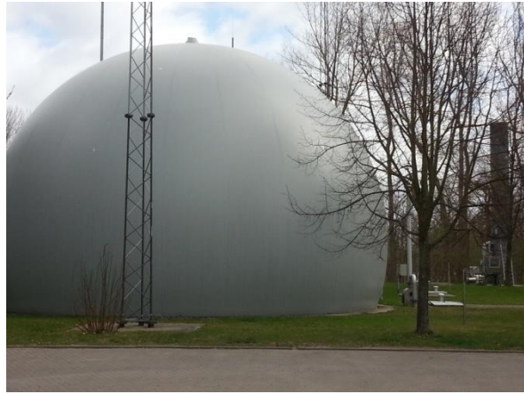
Zwischenspeicher (Druckbehälter) für Biogas
