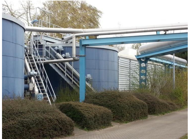
Koagulation und 2. biologische Behandlungsstufe (Nitrifikation)
