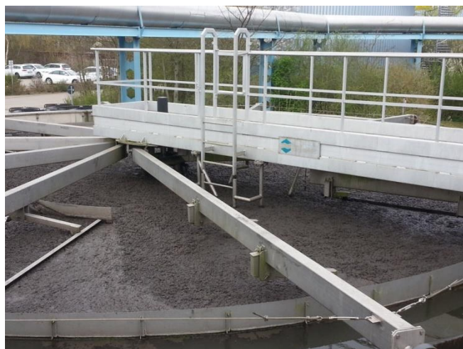
Schlamm-Eindickung (Entwässerung)
